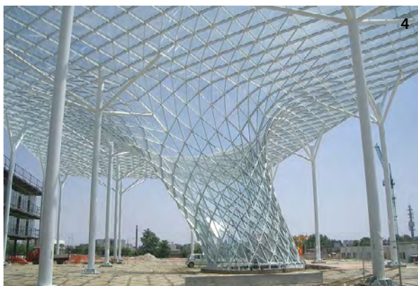
Fig. 4 - Mesh triangolare della Vela della Nuova Fiera di Milano (2002-2005). Fig. 5 - Nodo esavalente senza asse, con torsione geometrica
